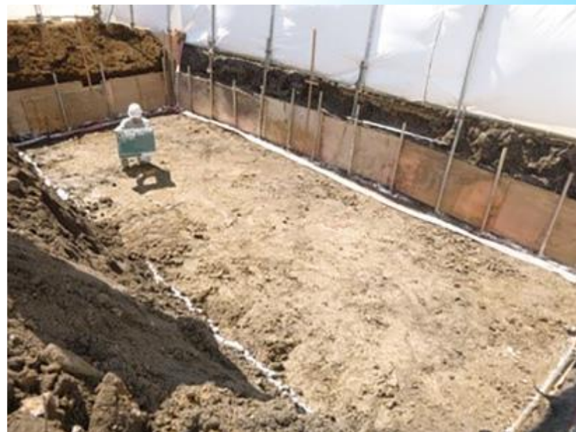
掘削除去工事
