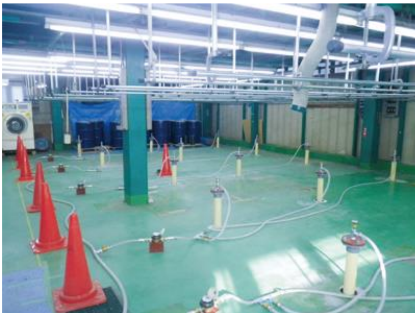
原位置浄化工事
